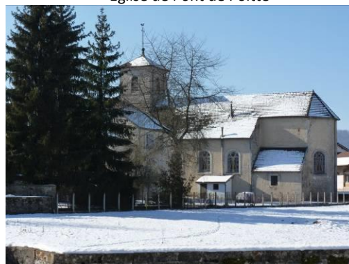
Eglise de Pont de Poitte
