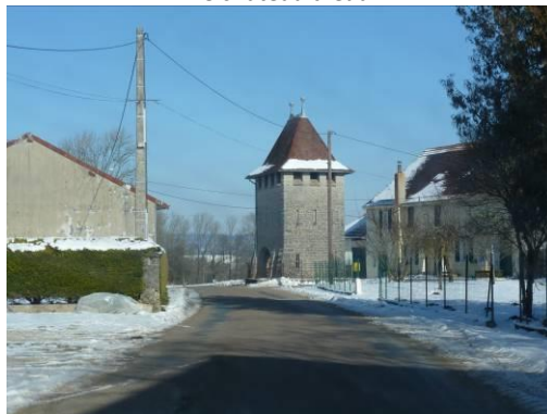
Le château d'eau
