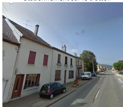
Stationnement sur le trottoir
