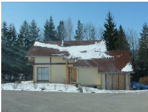
Maison ossature bois des années 2000
