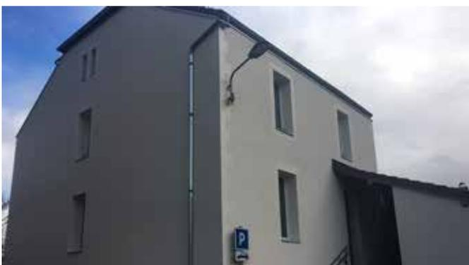
Ces travaux figurent au point n°1 de notre TEPCV et ont donc été subventionnés à 80%. Il s'agissait d'isoler les murs par l'extérieur et de changer les huisseries.
